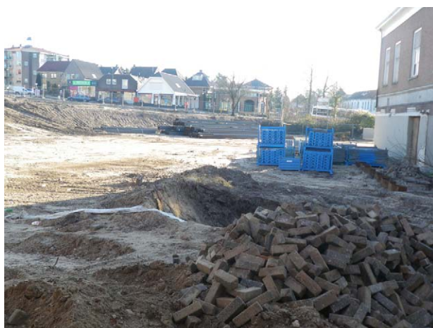
Afb. 3.3 Bouwhekken ter hoogte van werkput 1 (deel 3).
