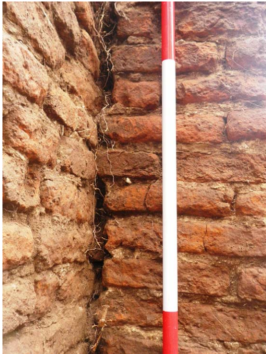
Afb. 6.7 De keermuur in het zuidelijke plangebied (werkput 1), gezien vanuit het zuidoosten met links de keermuur (spoor 1) en rechts de 'liseen' (spoor 4), die men aanvankelijk had aangebracht. Deze staat vrijwel koud tegen de keermuur. Plaatselijk is een verankering middels een baksteen aanwezig (Foto ADC ArcheoProjecten).
