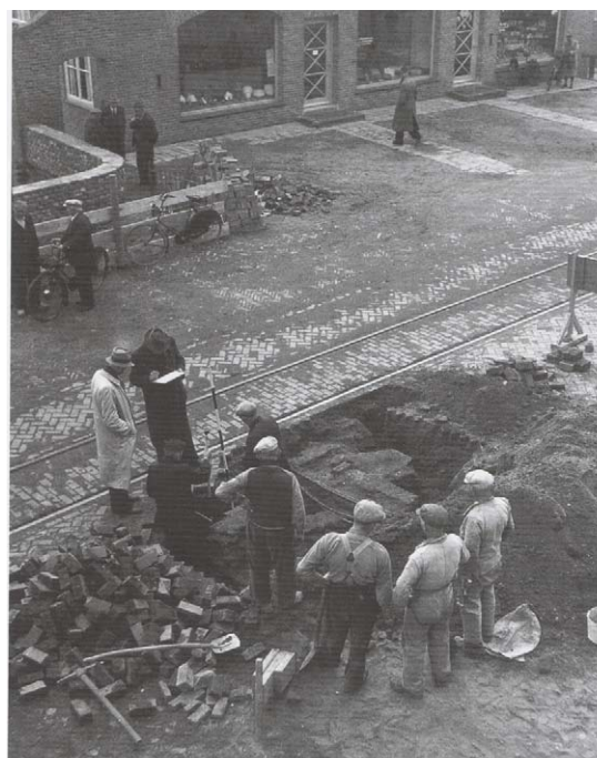
Afb. 2.8 Opgravingsfoto van de Bergpoort in 1943. Schoemaker 2008, p. 130.
