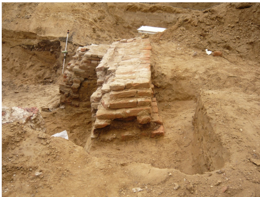
Afb. 6.16 Doorsnede van de keermuur (spoor 3) in het centrale deel van het plangebied (werkput 8), gezien naar het zuiden met links de zuidelijke steunbeer (spoor 2). De keermuur, die naar het oosten overhelpt, heeft slechts enkele versnijdingen in het fundament. De onderste lagen zijn als vlijlagen uitgevoerd. Aan de buitenzijde is een klamplaag aangebracht. Nog net zichtbaar is, dat de aarde aan de voet van de keermuur niet is weggegraven bij de bouw van de steunbeer. Alleen de buitenzijde is dieper gefundeerd. (Foto BBA).
