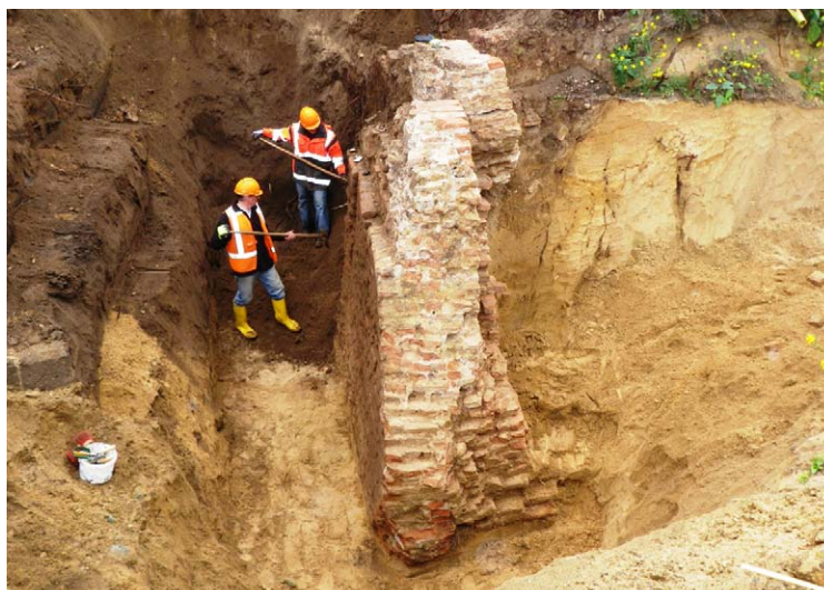
Afb. 3.10 Het blootleggen van de keermuur in samenwerking met dhr. T. Maas, gezien richting het zuiden.
