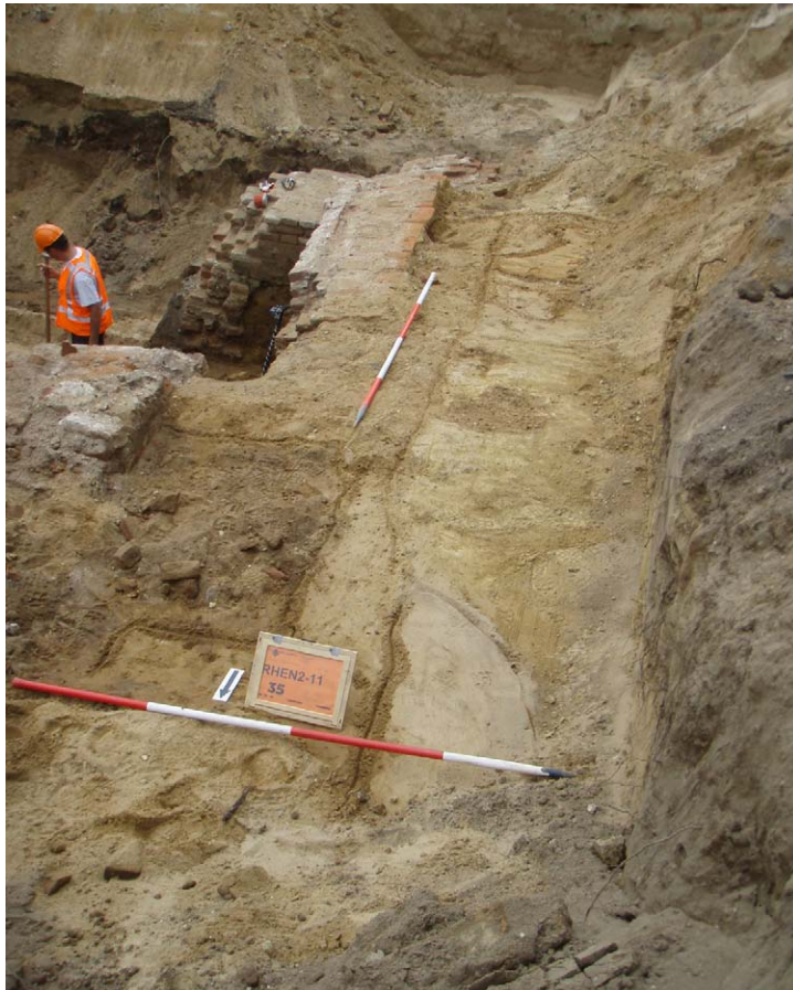
Afb. 6.18 Bovenaanzicht van de keermuur (spoor 3) met de beide steunberen (sporen 2 en 4) in werkput 8, gezien vanuit het noorden. Goed zichtbaar is dat de keermuur is gekanteld en om omvallen te voorkomen de steunberen gefaseerd zijn geplaatst. In het vlak is zichtbaar de insteek van het centrale deel van de muur en de uitbraaksleuf (zie ook afb. 6.14). Geheel links is de gracht (spoor 1). (Foto ADC ArcheoProjecten).
