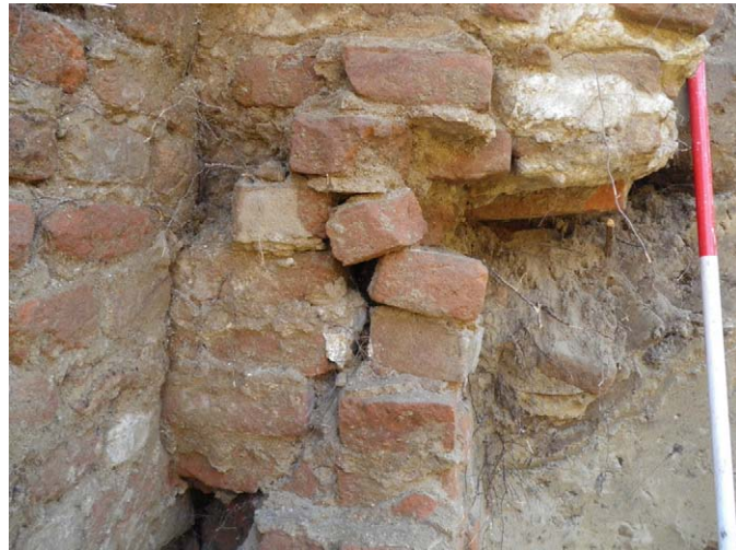
Afb. 6.8 Detail keermuur in het zuidelijke plangebied (werkput 1), gezien vanuit het noordwesten (stadszijde) met bovenzijde van de oorspronkelijke keermuur (spoor 1) met de insteek van spoor 3. Om te voorkomen dat de verhoogde keermuur zou omvallen, werd naderhand een brede steunmuur (spoor 5) met in het midden de 'verankering' van de steunmuur aan de keermuur. Waarschijnlijk is hier gebruik gemaakt van een gat in de oorspronkelijke keermuur (Foto ADC ArcheoProjecten).
