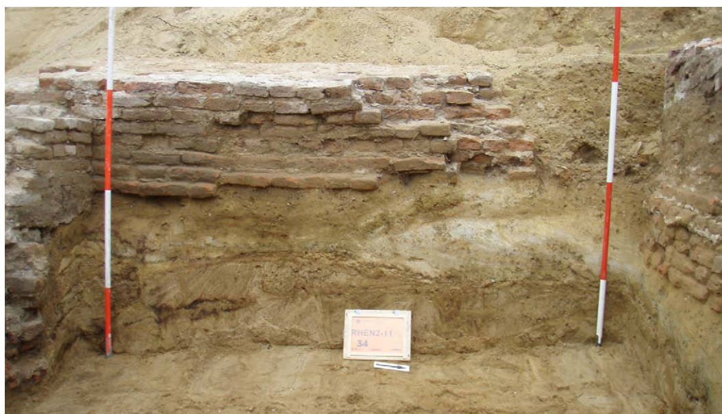
Afb. 6.17 Overzicht van de keermuur (werkput 8, spoor 3) in het centrale deel van het plangebied, gezien vanuit het oosten met in het midden de keermuur waarvan de onderste lagen baksteen versnijdingen hebben. Links de zuidelijke steunbeer (spoor 2), die dieper is aangelegd dan de muur zelf. Rechts de noordelijke steunbeer (spoor 4). Deze steunbeer is anders samengesteld dan de zuidelijke steunbeer. De steunbeer heeft een fundering van zes lagen baksteen, waarvan de vier onderste lagen baksteen niet met kalk, maar met zand opgetrokken zijn. De twee bovenste lagen, die met kalkspecie opgetrokken zijn, hebben nog forse speciebaarden. (Foto ADC ArcheoProjecten).
