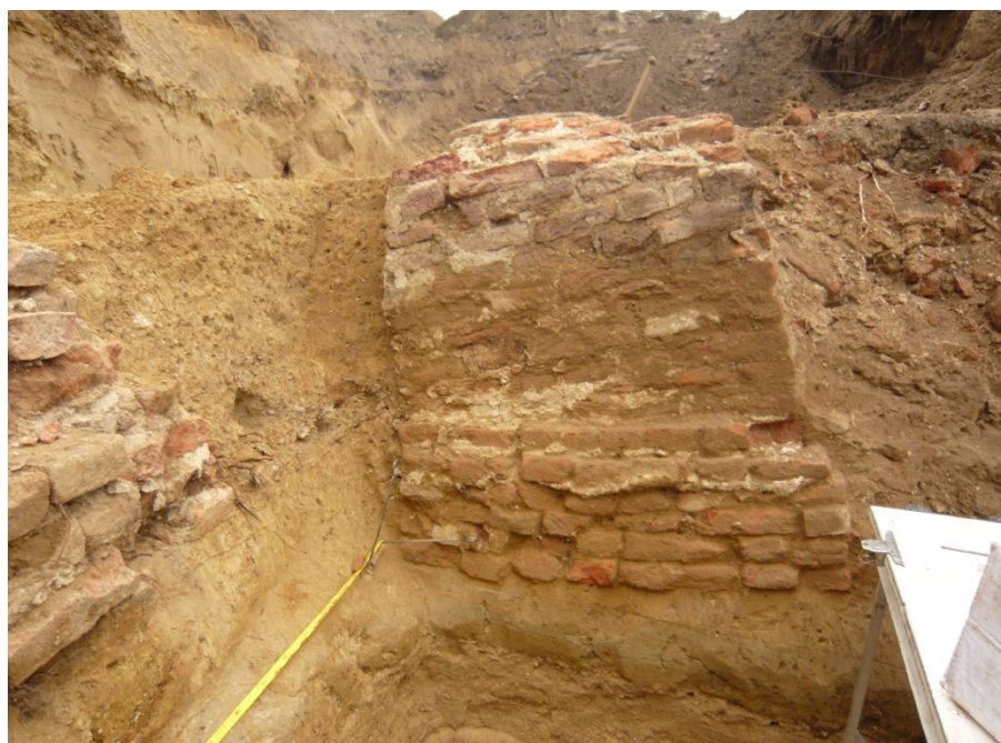
Afb. 6.20 De noordelijke steunbeer (werkput 8, spoor 4), gezien vanuit het zuiden. Links de keermuur, die ter plaatse van de steunbeer is verdwenen. De steunbeer bestaat aan de onderzijde uit een bakstenen 'fundament' van zes lagen baksteen en is daardoor een iets smallere steunbeer dan de zuidelijke. De lagen erboven zijn als een 'varken', dus schuin, gemetseld, waardoor ze met het volle gewicht tegen de keermuur zijn gebouwd. De onderste vier lagen van het 'fundament' waren als vlijlagen uitgevoerd. Ze zijn niet met mortelspecie gemetseld. De twee lagen daarboven vertonen zeer forse mortelbaarden, die aantonen dat dit gedeelte zich onder maaiveld bevond. (Foto BBA).
